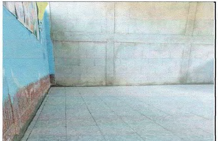
Foto 4: Finalización de mejoramiento de división de aula.
