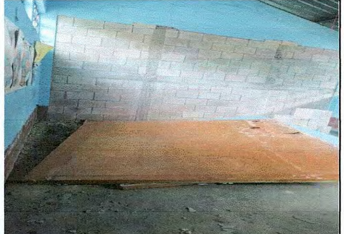
Foto 2: Finalización de mejoramiento de división de aula.
