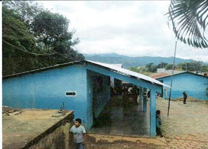
Foto 2: Cambio de lámina finalizado.
