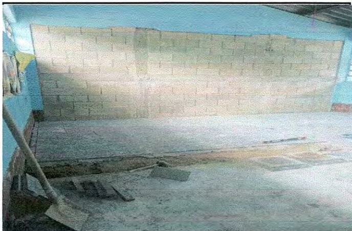
Foto 3: Finalización de mejoramiento de división de aula.
