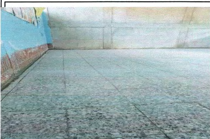
Foto 3: Cambio de piso de granito finalizado.
