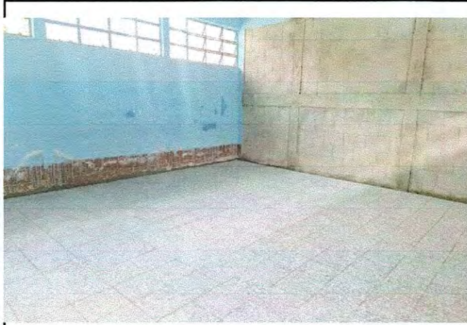
Foto1: Finalización de mejoramiento de división de aula.
