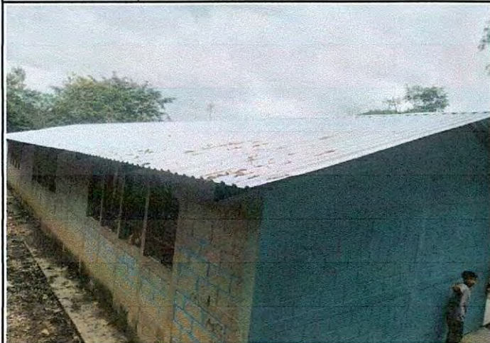
Foto1: Cambio de lámina finalizado
